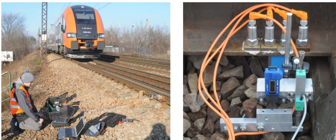
Rys. 4 Pomiary testujące czujniki przyspieszeń oraz czujniki ugięć dynamicznych nawierzchni
