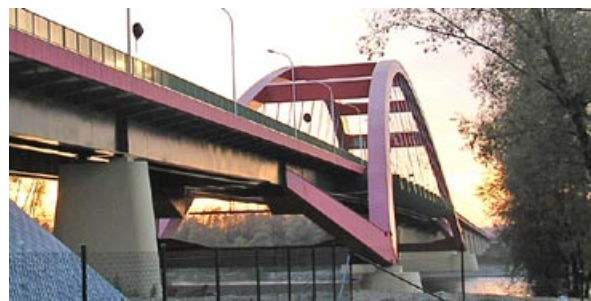
Fot. 1. Widok przęsła łukowego mostu od strony ul. Dęblińskiej
